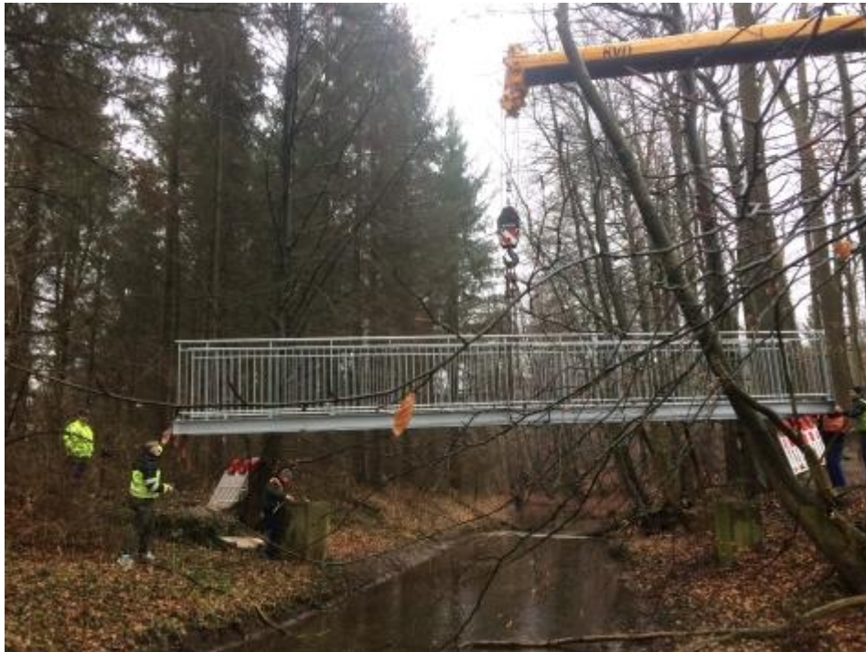
Brückenmontage -Foto von A. Gehrs (NOZ)
